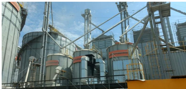
Figura 8: Centro de almacenamiento de planta arrocera
