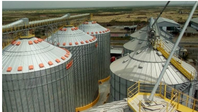
Figura 6: Silos de planta arrocera Sullana; Piura
