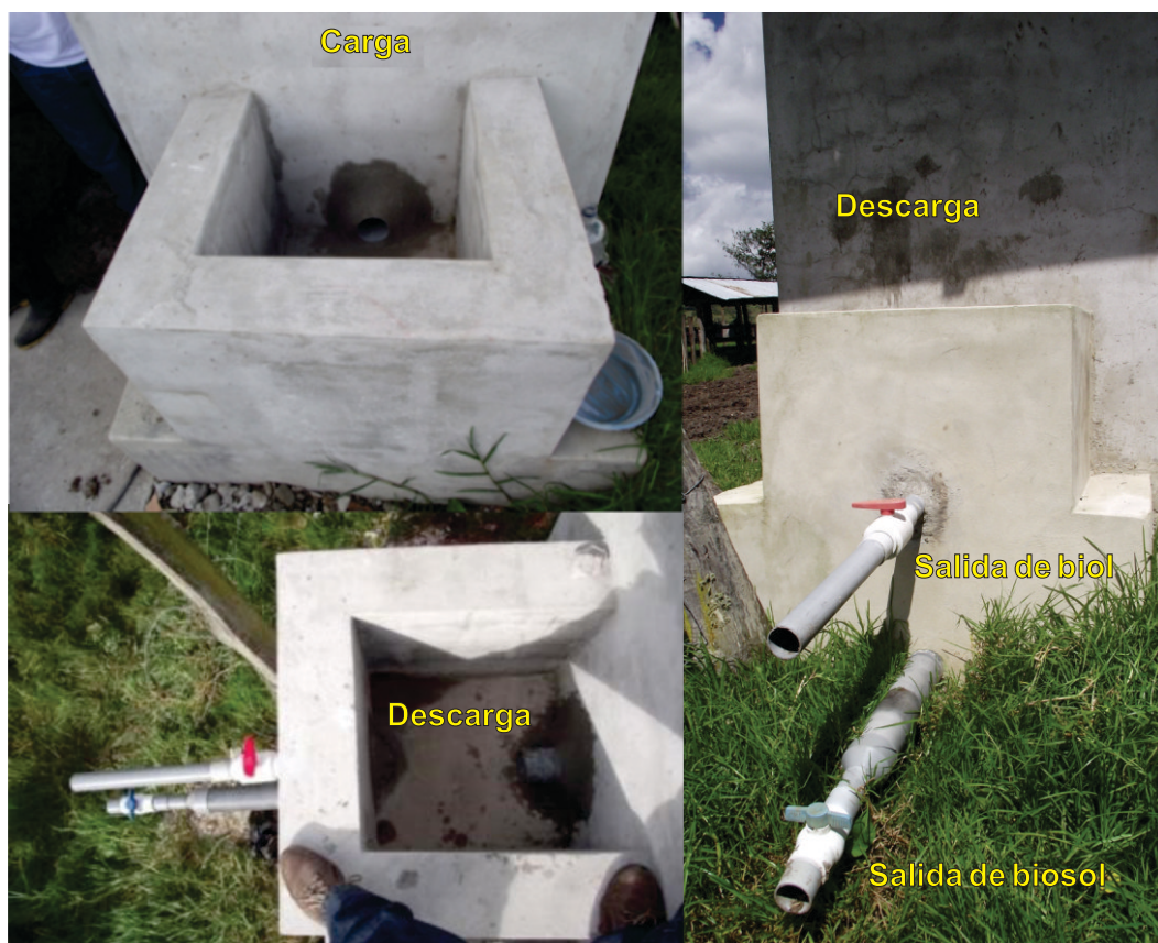
Figura 54. Fijación de tuberías a las pozas de carga y descarga del sistema instalado en Pomacochas.
