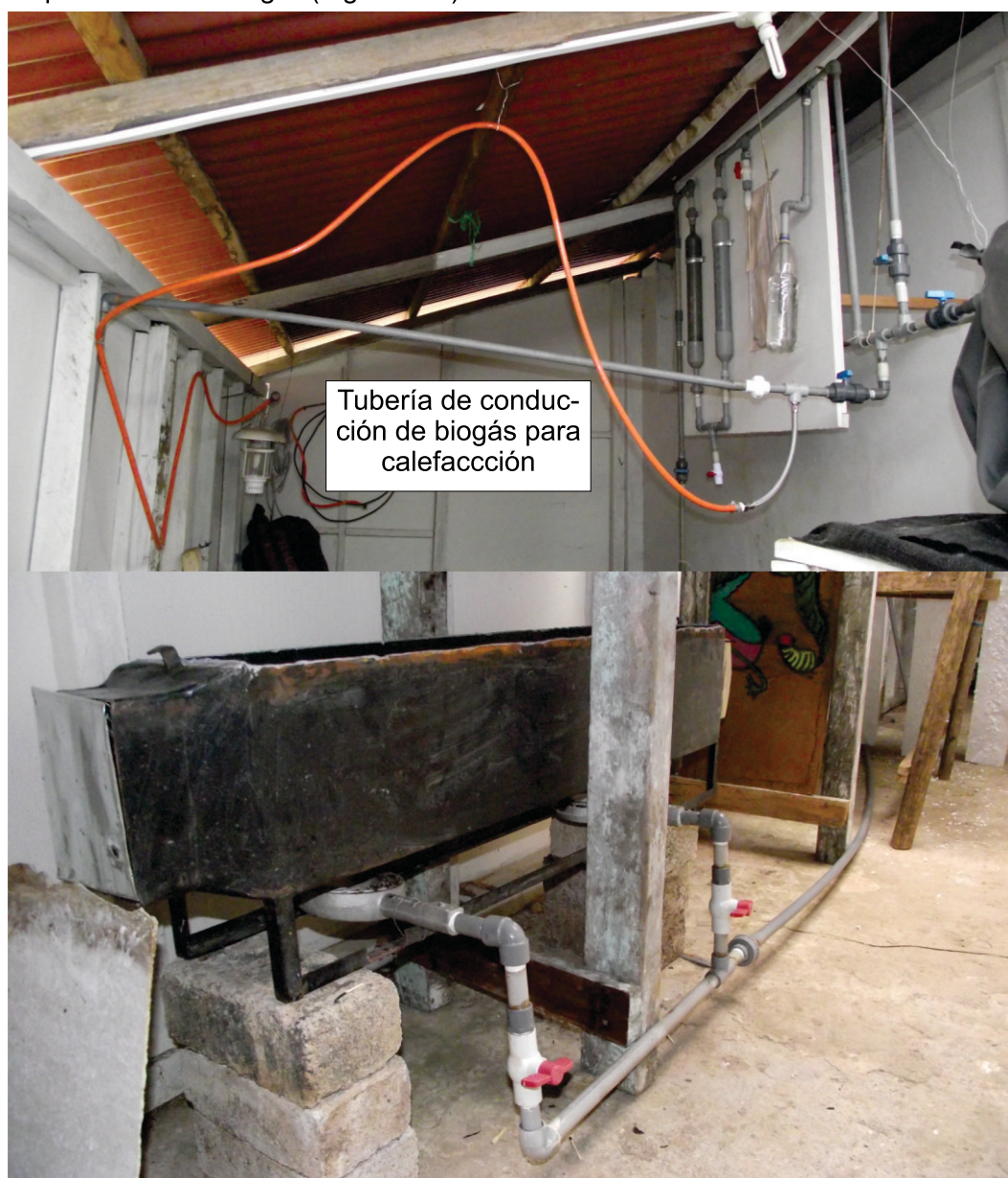
Figura 132. Sistema de calefacción a biogás.
