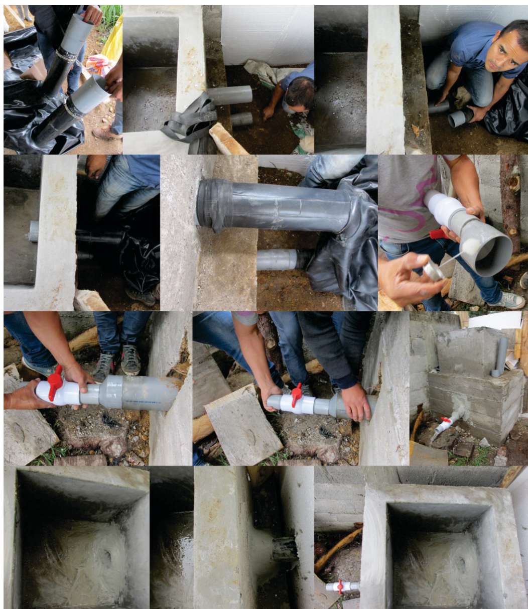
Figura 58. Conexión del biodigestor a la tubería de fondo para salida de biosol y a la poza para salida de biol. Colocación de la llave para salida de biosol y fijación de los tubos con “diablo”.
