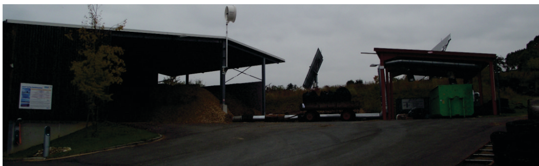
Figura 150. Área de secado de chips de madera con aire caliente.
