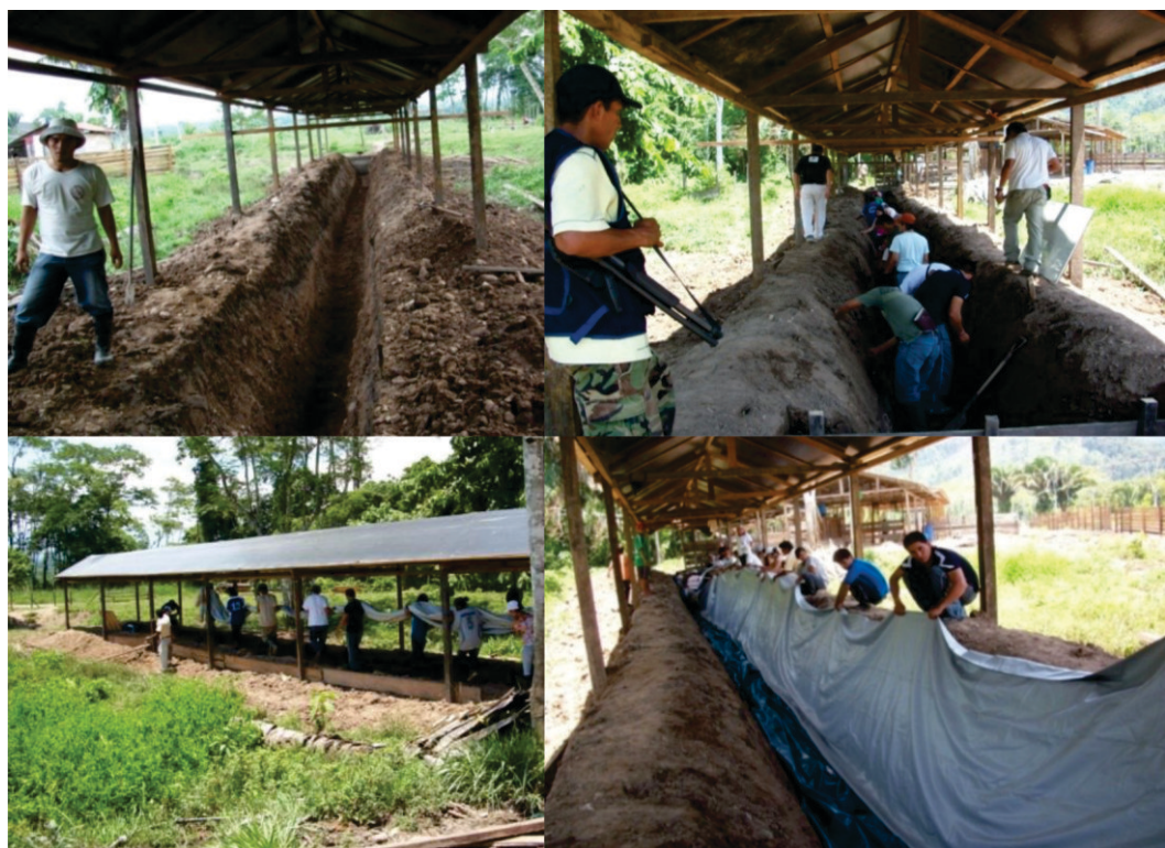
Figura 62. Poza para el biodigestor. Traslado y colocación del biodigestor en la poza, como protección se colocó una manta de polietileno.
