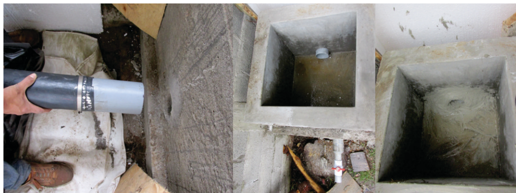
Figura 57. Conexión del biodigestor a la poza de carga o alimentación y fijación del tubo con "diablo" para fraguado rápido.
