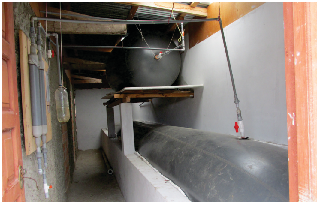
Figura 90. Biodigestor en operación en Pomacochas, a 10 cm de presión de agua.
