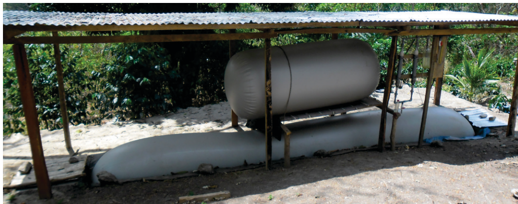
Figura 26. Biodigestor tubular o de flujo pistón (inferior) y su gasómetro.
