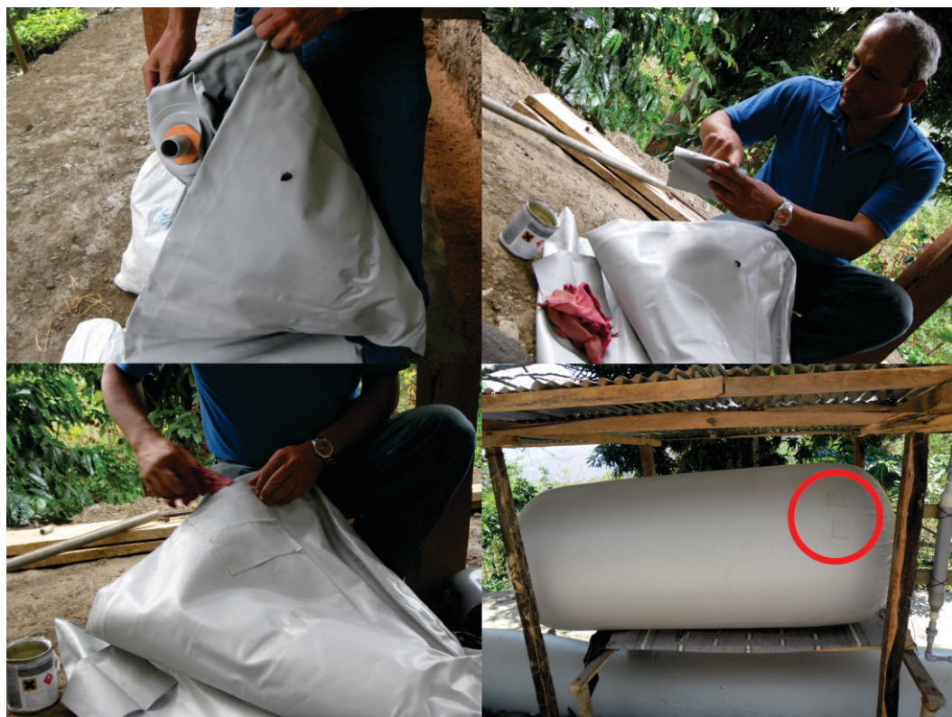
Figura 78. Parchado de geomembrana de PVC.
