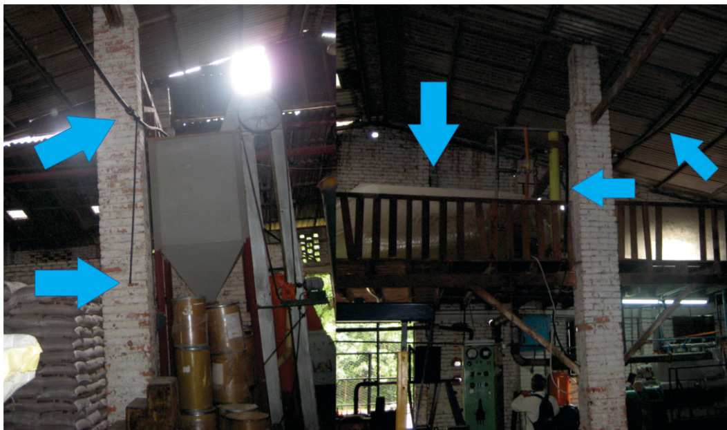
Figura 104. Drenaje de agua, balón de manga de polietileno para almacenar el biogás para los motores y segundo cartucho para eliminar el H_2S remanente.
