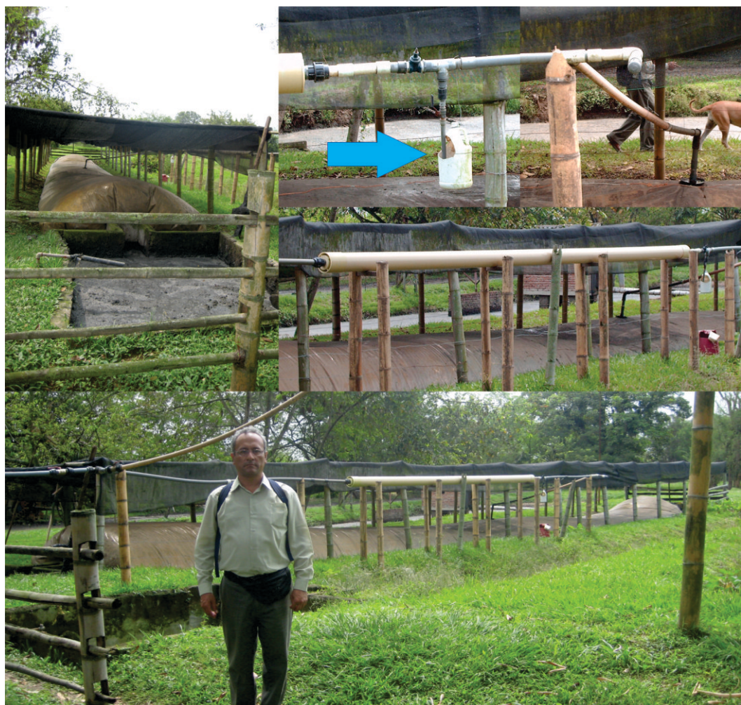
Figura 103. Biodigestor de la Granja Pozo Verde, Cali – Colombia. La flecha señala el regulador de presión del sistema.
