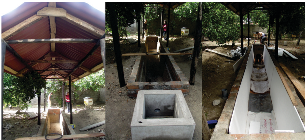
Figura 63. Poza para el biodigestor en Cumba.
