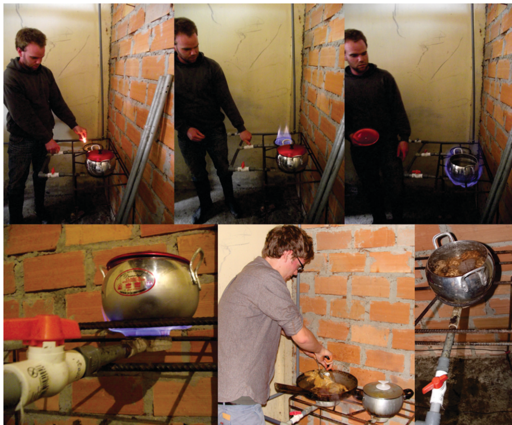
Figura 92. Cocina a biogás en Pomacochas.
