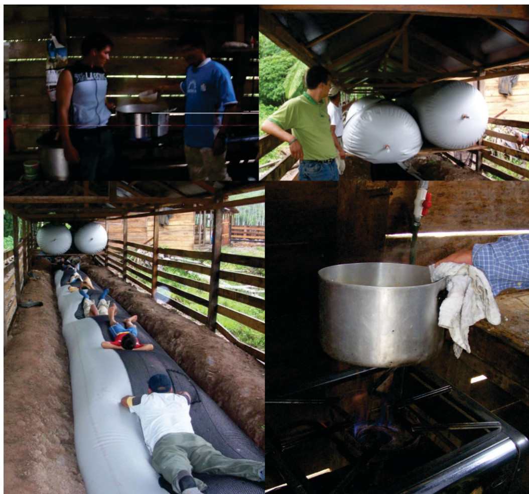
Figura 89. Biodigestor de la Ganadería Renacer en producción a los 18 días de cargado. Seis personas están sobre la campana del biodigestor llena con biogás. La cocina no tizna la olla.
