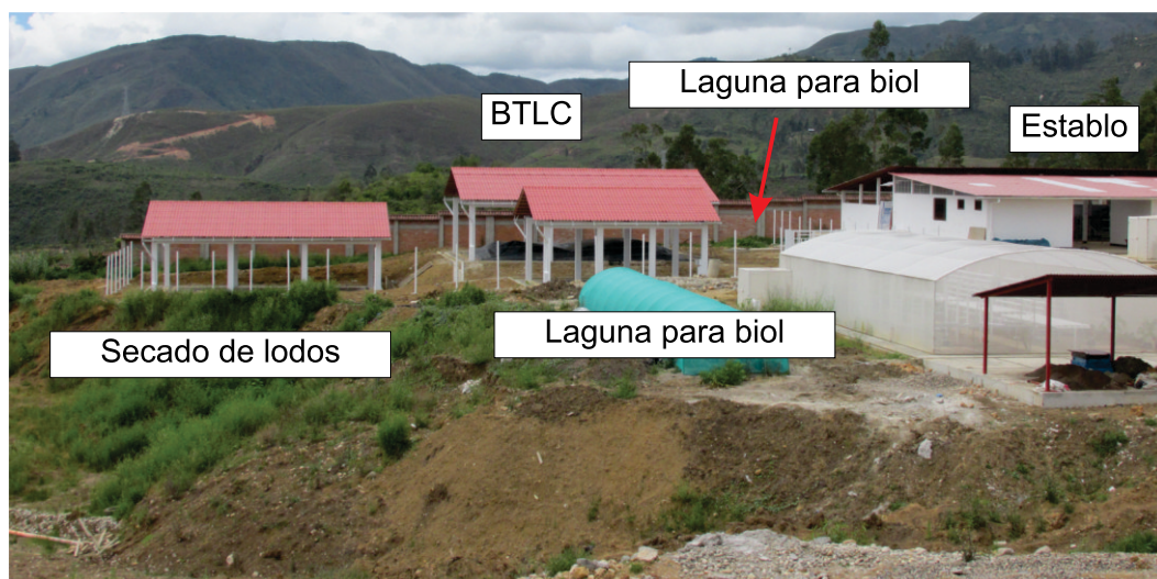
Figura 173. Ubicación de los componentes del sistema de producción de biogás en la UNTRM, Amazonas – Perú.
