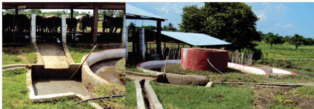
Figura 24. Esquema del biodigestor chino. Alimentación del biodigestor con el lavado del piso del cobertizo.
