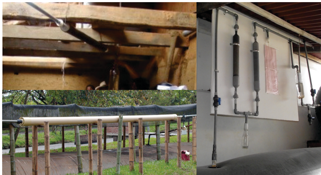
Figura 22. Cartuchos con viruta o clavos de hierro para eliminar el H_2S .
