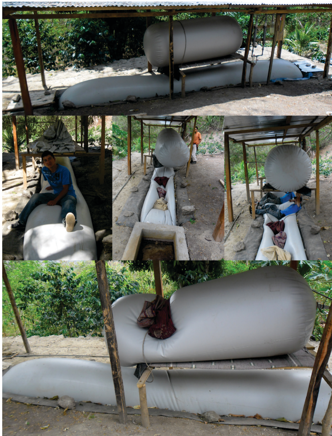
Figura 134. Acciones para incrementar la presión del biogás disponible.
