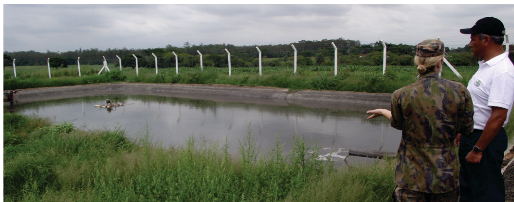
Figura 115. Laguna para almacenar biol para fertirriego.
