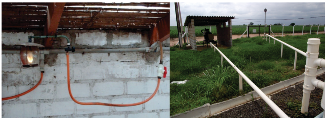
Figura 3. Biogás producido en un biodigestor usado como combustible en una lámpara, un grupo electrógeno y una antorcha.
