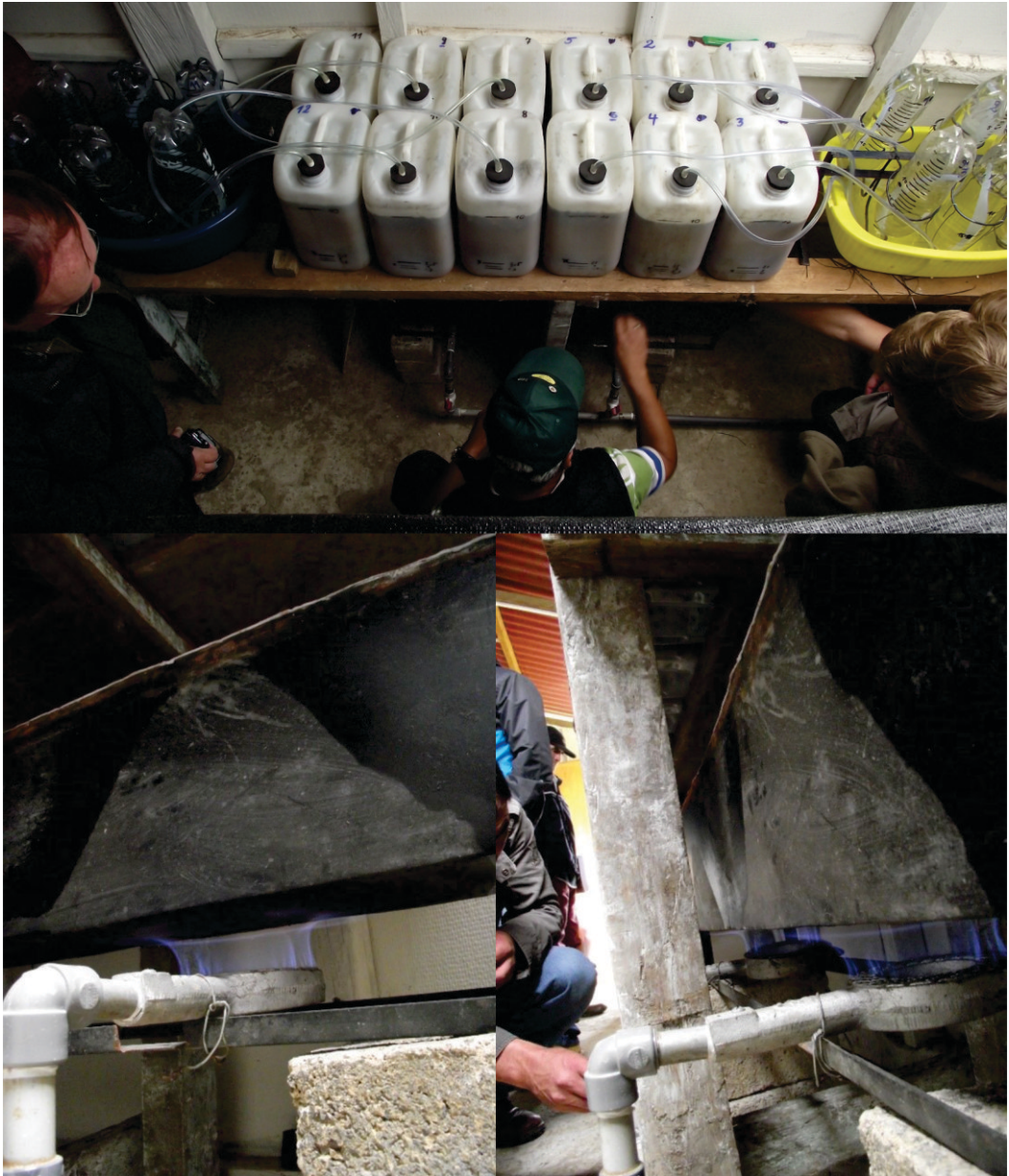
Figura 133. Operación del sistema de calefacción a biogás.
