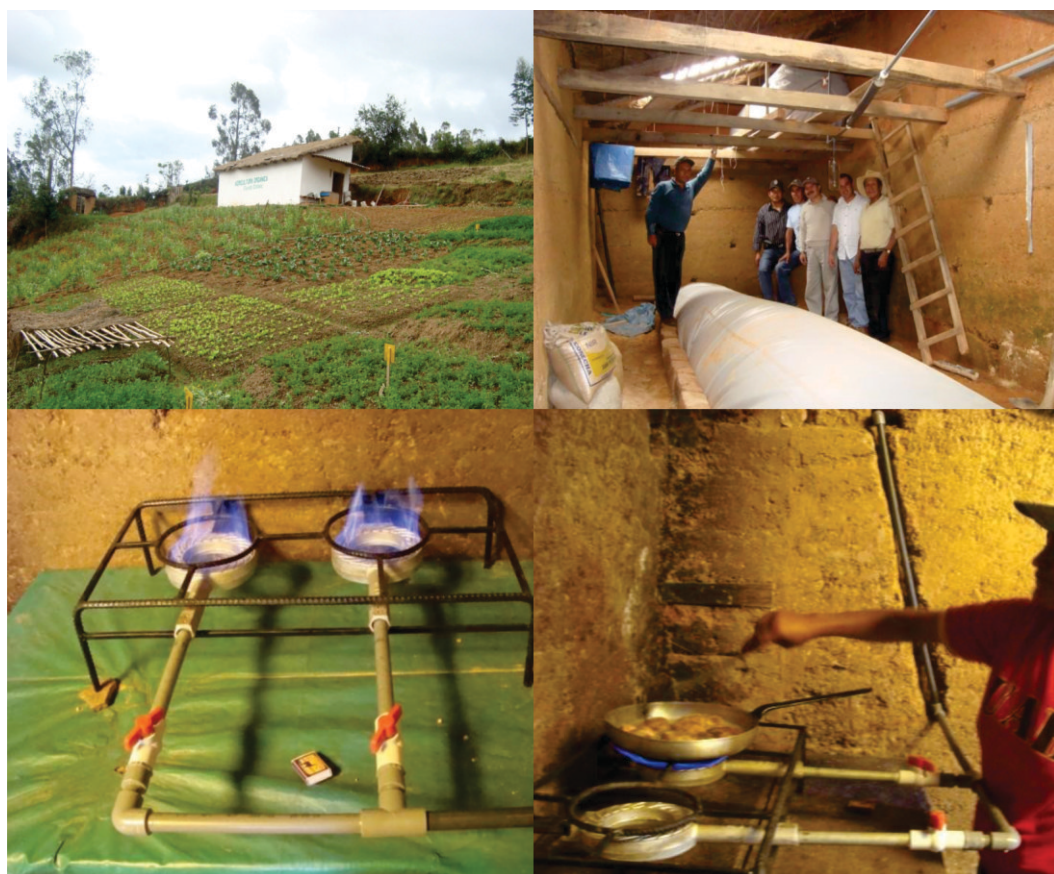
Figura 88. Caseta donde se instaló el biodigestor en Santo Tomás y preparación de alimentos en la cocina a biogás.
