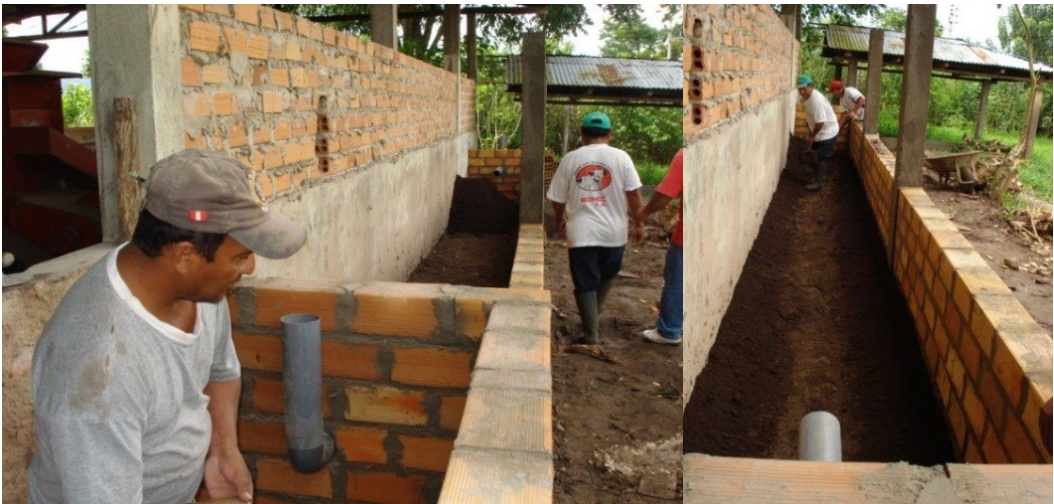
Figura 49. Boca de carga, poza para el biodigestor (10 m de largo x 1 m de ancho x 1 m de alto) y al fondo boca de descarga. Se colocó tierra para eliminar el ángulo en el fondo, a lo largo de la poza para el biodigestor.
