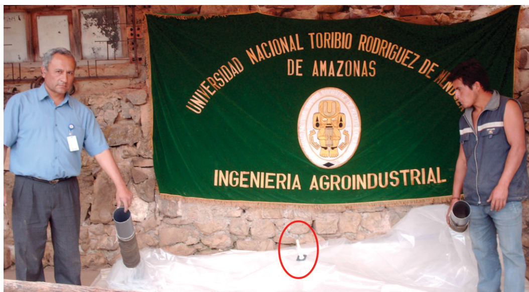
Figura 35. Biodigestor de manga de polietileno de 3 m de largo y 2 m de circunferencia listo para ser llenado con la mezcla estiércol-agua, en el Camal de Chachapoyas.
