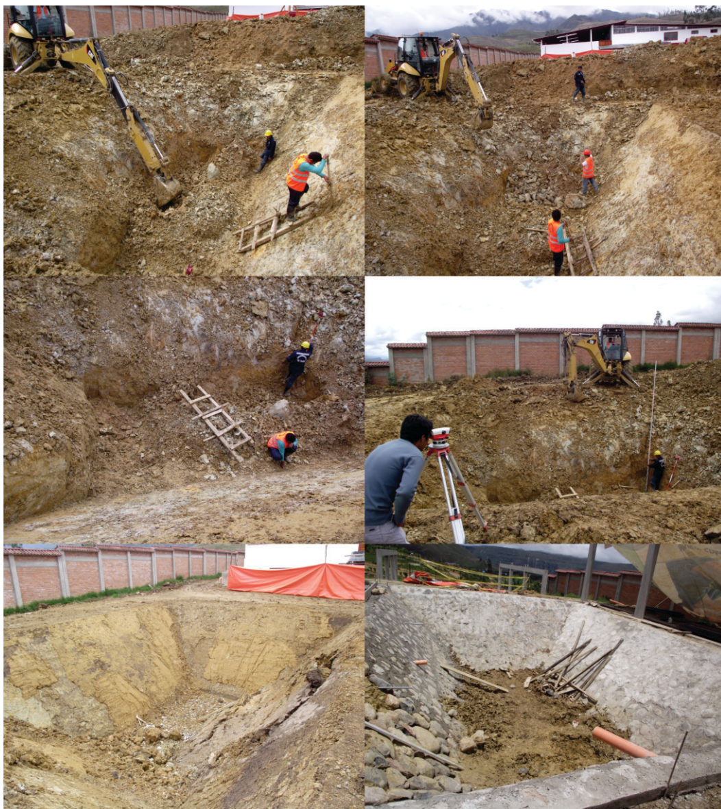
Figura 163. Excavación y reforzado de la cámara del BTLC.
