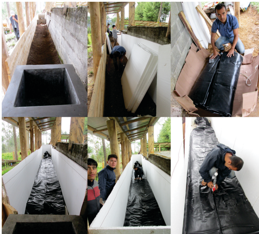
Figura 56. Colocación de tecnopor en la poza para el biodigestor como aislante térmico y protector. Colocación de la llave para salida de biogás.
