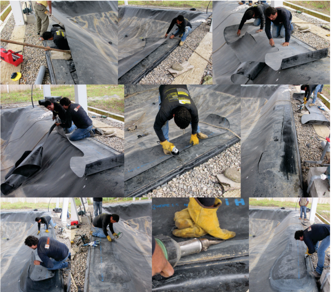
Figura 184. Parchado de la geomembrana del biodigestor.
