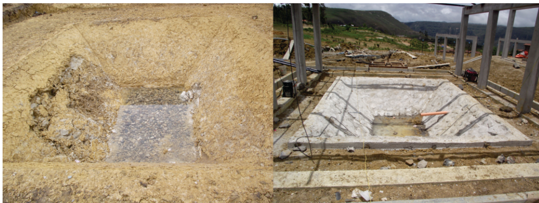
Figura 168. Excavación y reforzado de la laguna secundaria.
