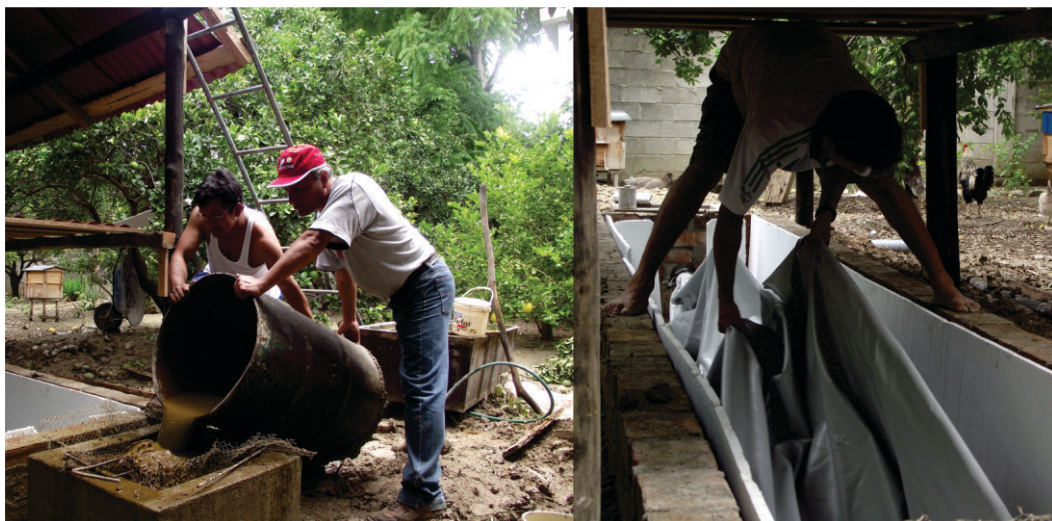
Figura 67. A la vez que se va cargando el biodigestor, se lo debe ir jalando hacia arriba a todo lo largo para evitar que se formen pliegues en el fondo y el biodigestor quede deformado por ello.
