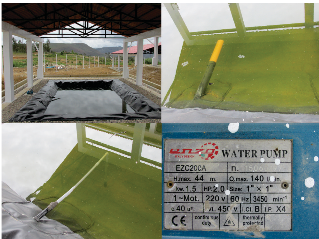
Figura 169. Laguna secundaria terminada. Tubería que conduce el biol del digestor. Tubería de succión de la electrobomba de 2 hp para envasar biol o bombearlo al campo como abono orgánico.
