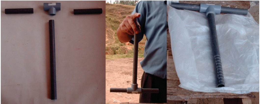
Figura 38. Preparación de la te para el balón de almacenamiento de biogás, y para el regulador de presión; a esta última se le hicieron marcas con la sierra cada 1 cm para facilitar la lectura de la presión.
