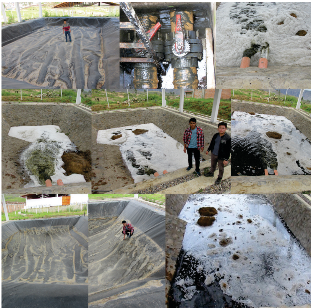
Figura 183. Evacuación total del BTCL.
