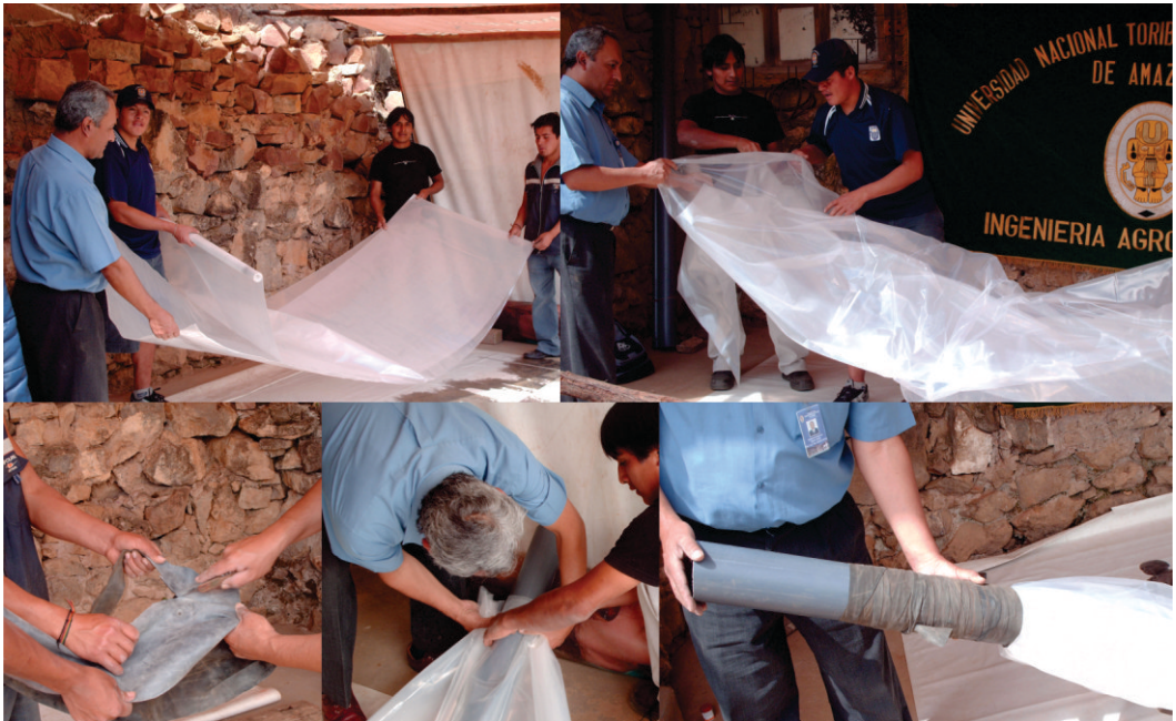
Figura 33. Armado del biodigestor de 3 m de largo de manga de polietileno.
