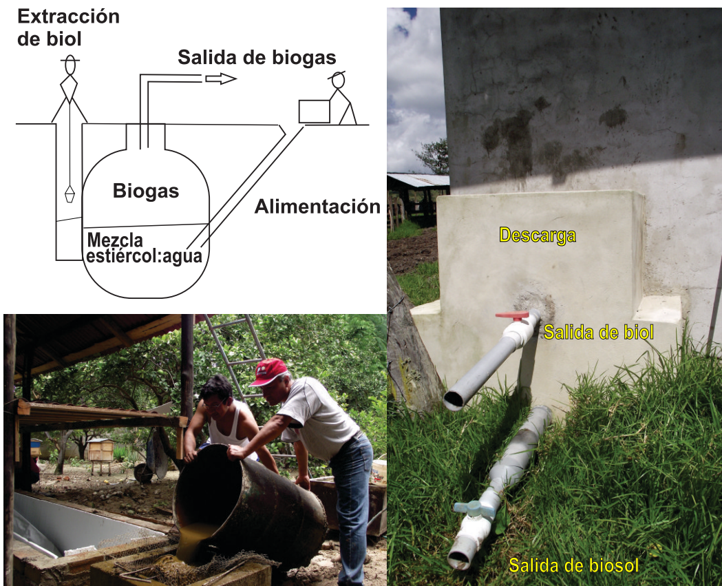
Figura 21. Sistemas de carga y descarga del biodigestor.
