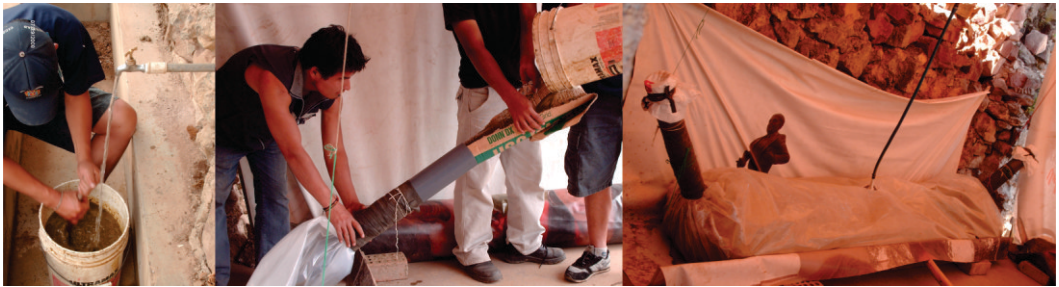
Figura 36. Preparación de la mezcla estiércol-agua y llenado del digestor hasta el 75% de su volumen total, el resto será ocupado por el biogás.
