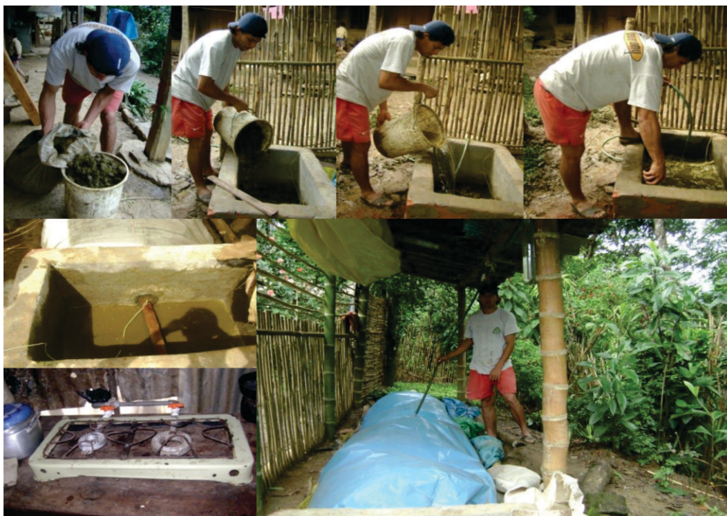
Figura 42. Preparación de la mezcla estiércol:agua (1:5) en poza de carga y alimentación del biodigestor. Cocina lista para usar, biodigestor y balón llenos de biogás.
