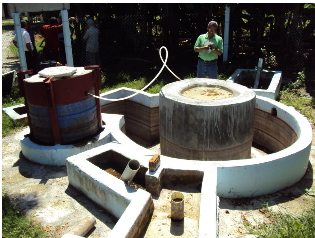
Figura 25. Biodigestor tipo hindú (izquierda) y tipo chino (derecha) con cámara de compensación.
