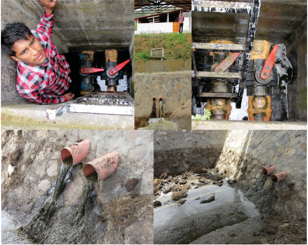
Figura 182. Extracción de biosol del BTLC.
