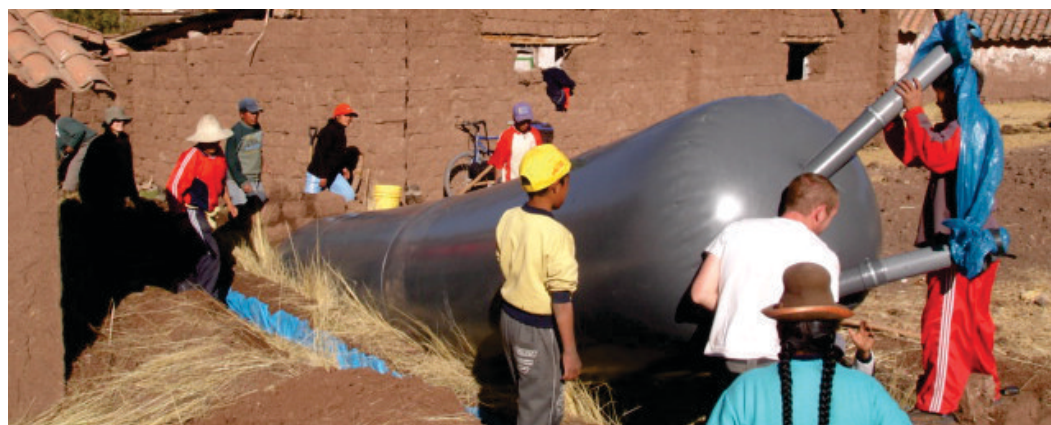
Figura 45. Biodigestor tubular de geomembrana de PVC inflado con aire para facilitar su instalación. (Cortesía de CIDELSA).
